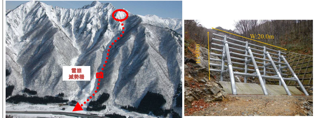
雪崩発生斜面全景 1)
