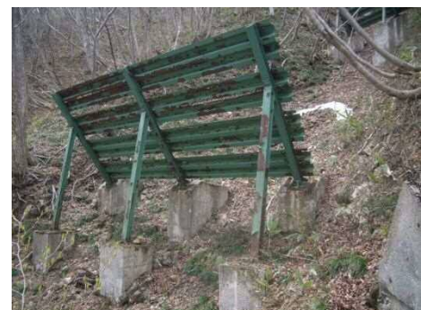
図8 一般的な雪崩予防柵(単独基礎) 1)
