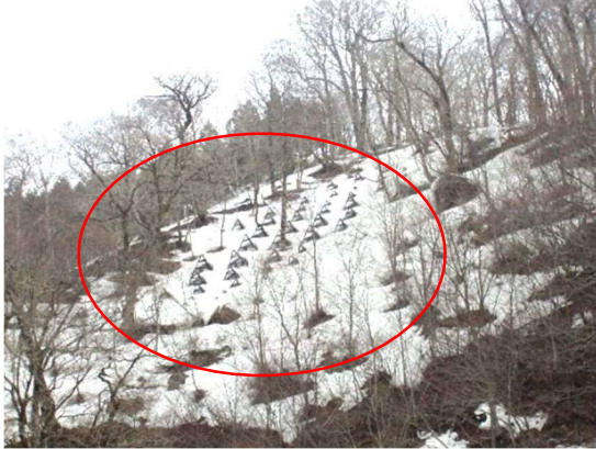
図14 多段に設置された吊柵
