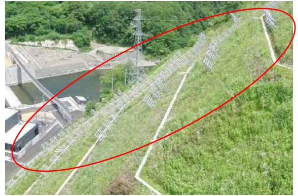
図16 多段に設置された吊柵
