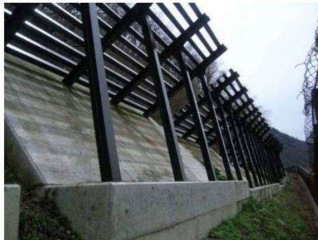
図9 一般的な雪崩予防柵（連続基礎） 1)
