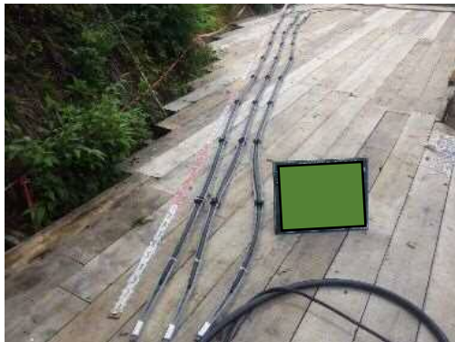
図19 ワイヤロープアンカー
