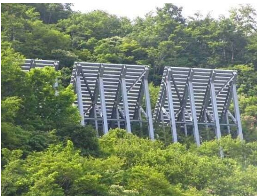
図10 設計積雪深12mに対応した雪崩予防柵
