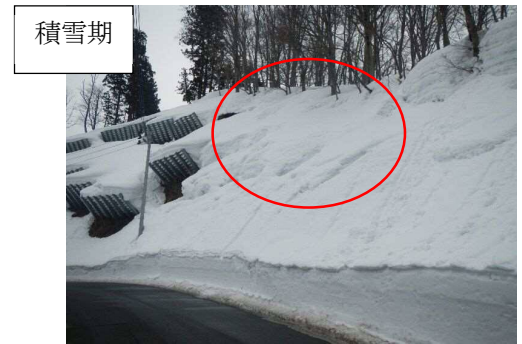
図7 雪崩予防杭の効果検証事例(斜面勾配55°)
