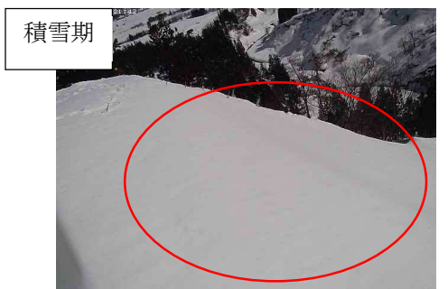
図6 雪崩予防杭の効果検証事例(斜面勾配50°)
